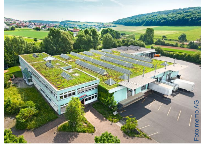
Dachbegrünung auf Firmengelände
