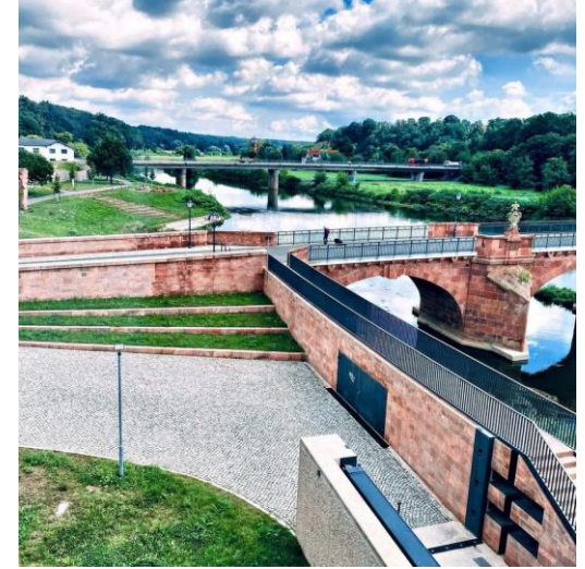
Hochwasserschutzmauer in Grimma
