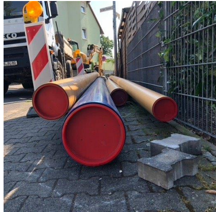
Rohre für den Kanalisationsausbau
