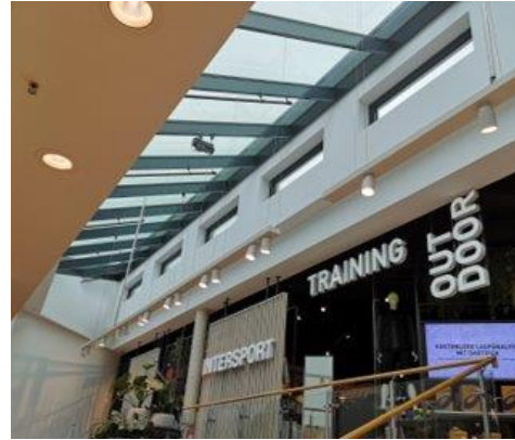
Nachtlüftungsfenster (Innen- und Außenansicht)
