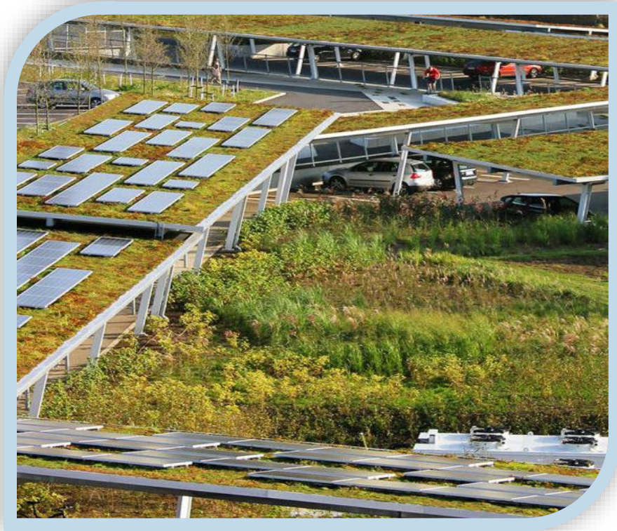
Abb. 1: Parkplatzüberdachung mit Grün + PV, Quelle: www.worldlandscapearchitect.com
